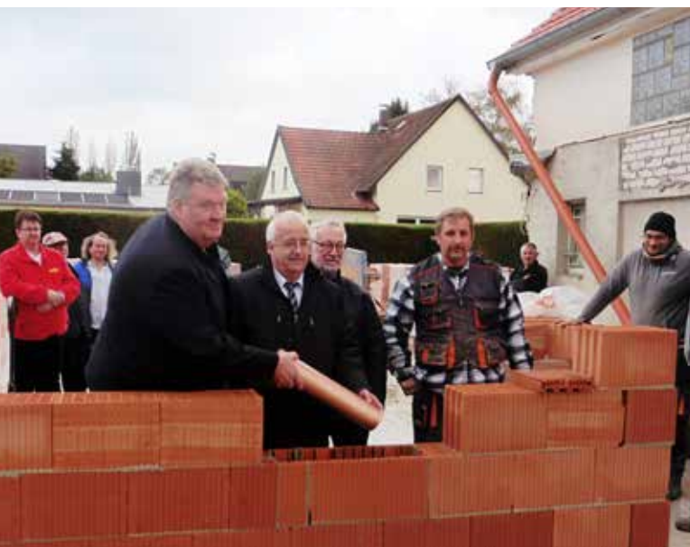
Jens Meier, Friedbert Mordfeld und Hartmut Ehlert (v. l.) versenken die Edelstahlhülle, Harry Winkler kümmert sich um die Maurerarbeiten
